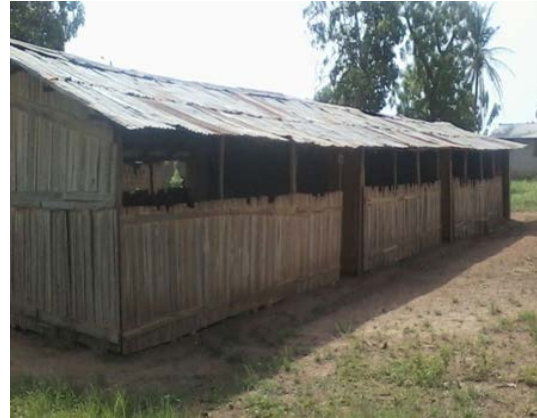
Trois salles de classe construites dans le cadre de la mise en œuvre du PAC
